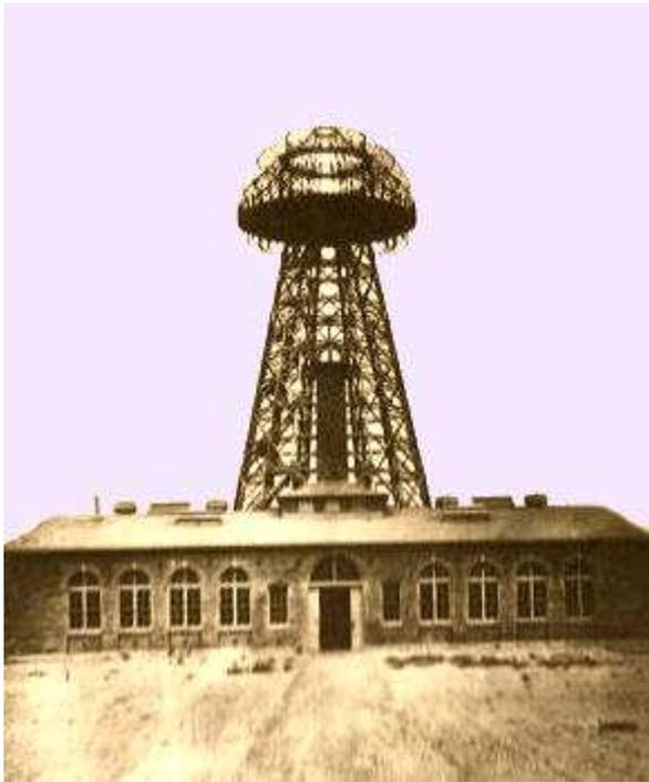
**Progetto di torre per la trasmissione wireless**
